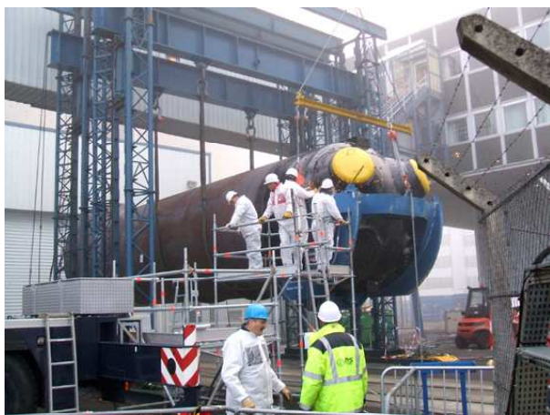
Transfert du nouveau Générateur dans le bâtiment où il sera mis en place
