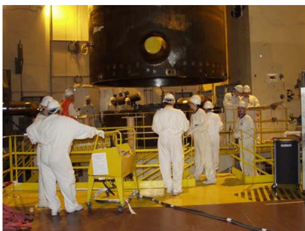
Mise en place du nouveau Générateur de Vapeur
