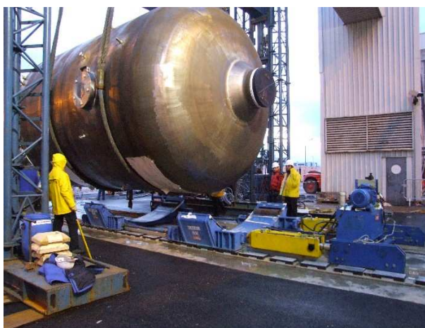
Transfert du nouveau Générateur dans le bâtiment où il sera mis en place
